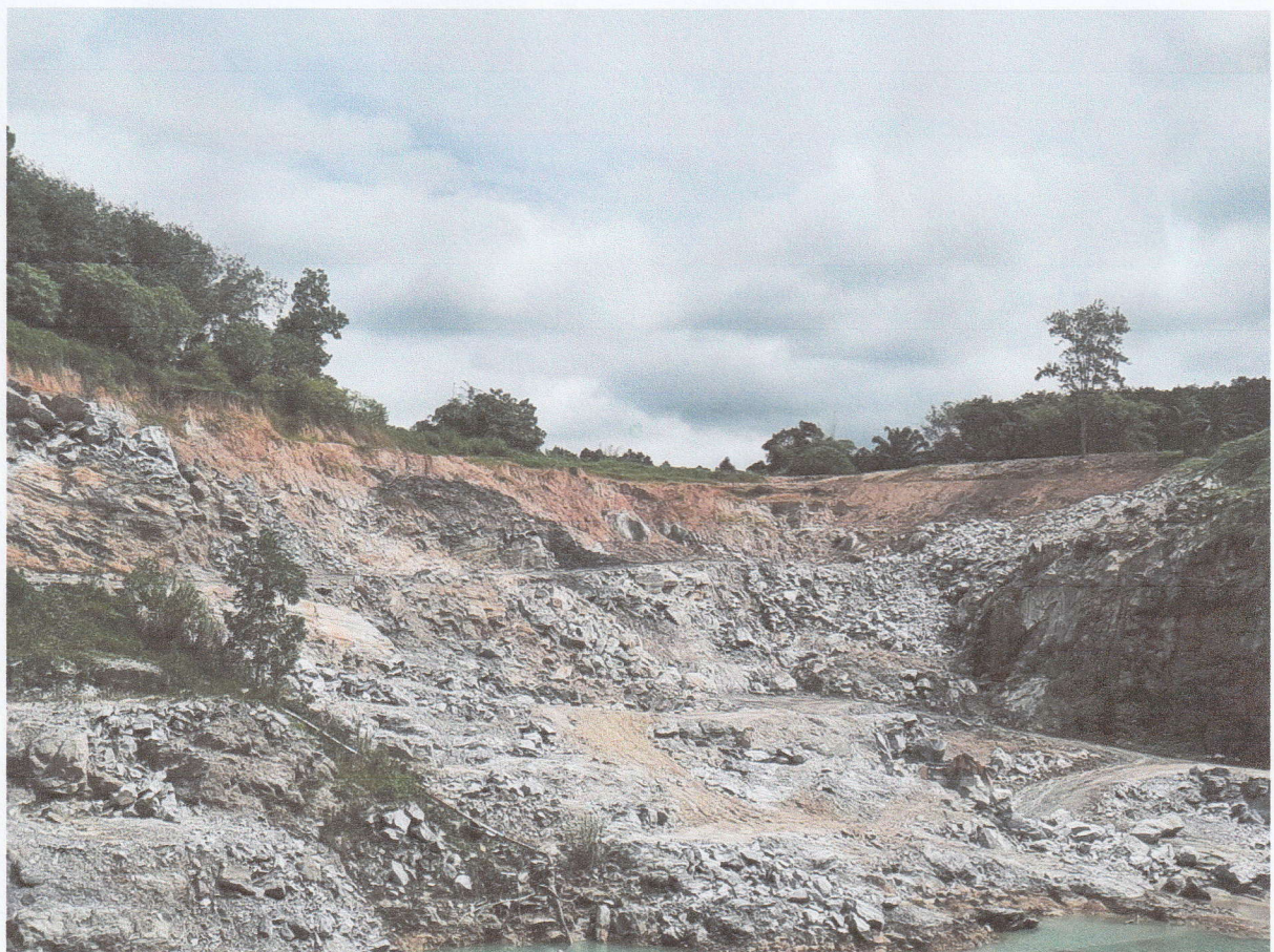
1. การปรับปรุงหน้าดินและชั้นดินบริเวณขอบบ่อทางด้านทิศเหนือของโครงการที่มีน้ำซึมผ่าน
